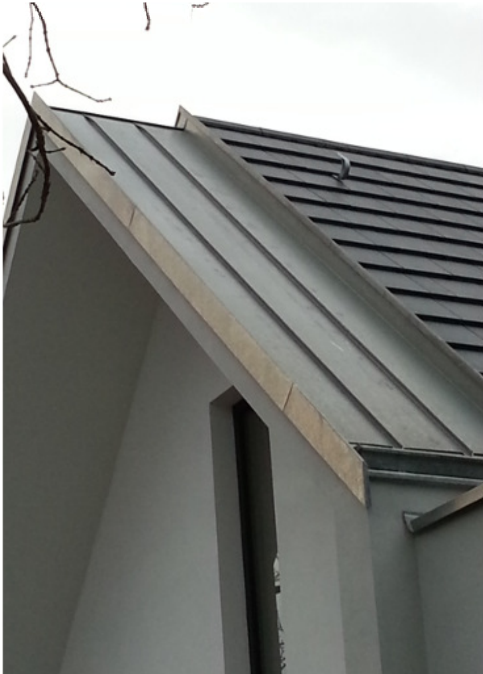
Blick auf die fertige Ortausbildung mit Stehfalzdeckung in Titanzink
