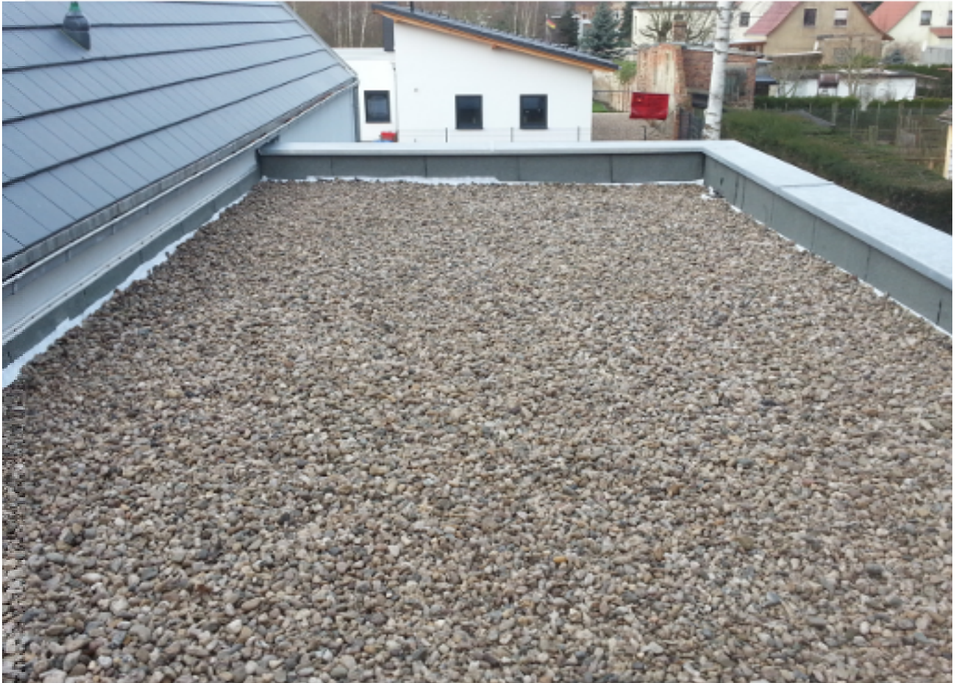
Blick auf den Flachdachbereich nach aufbringen der Kiesschicht
