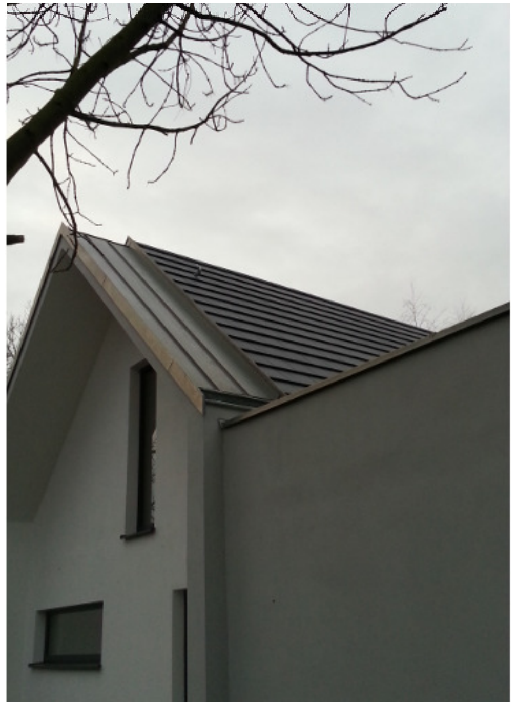
Blick auf die fertige Ortausbildung mit Stehfalzdeckung in Titanzink
